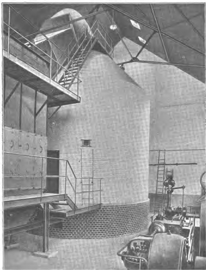
Installation pour la dessiccation du lait et de la caséine à Gronau, Appareil évaporant 1.000 litres d'eau à l'heure. Remarquer la porte donnant accès dans la tour et la fenêtre permettant d'observer l'intérieur de la tour.
