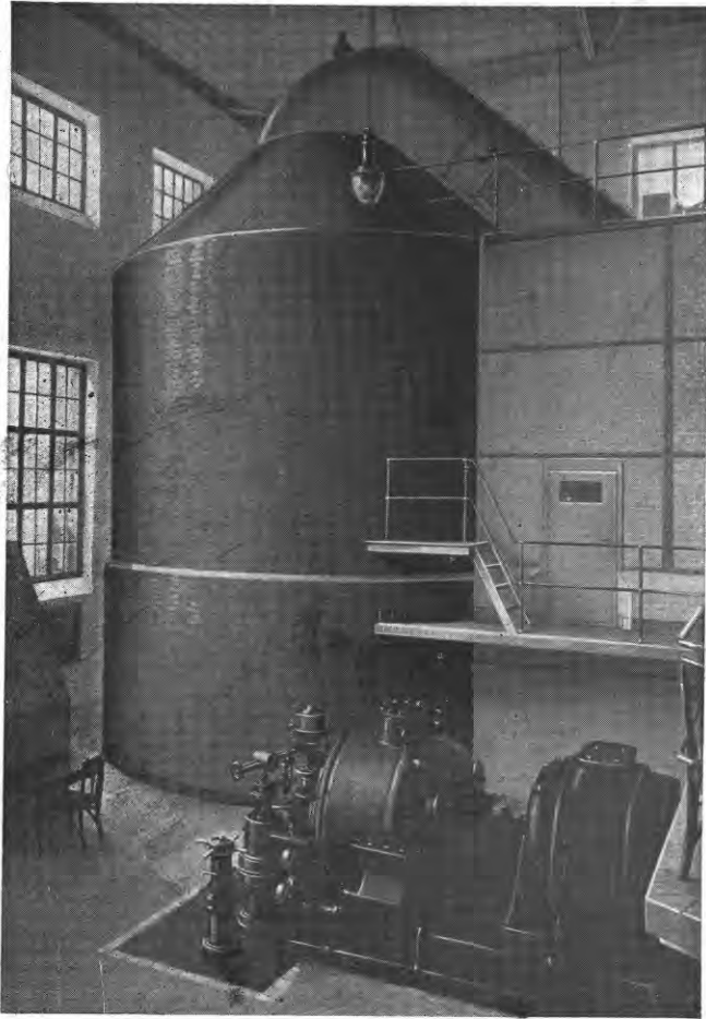
Un des deux appareils des Etablissements laitiers à Schlachter (Bavière). Type 1000 litres d'eau à l'heure.
